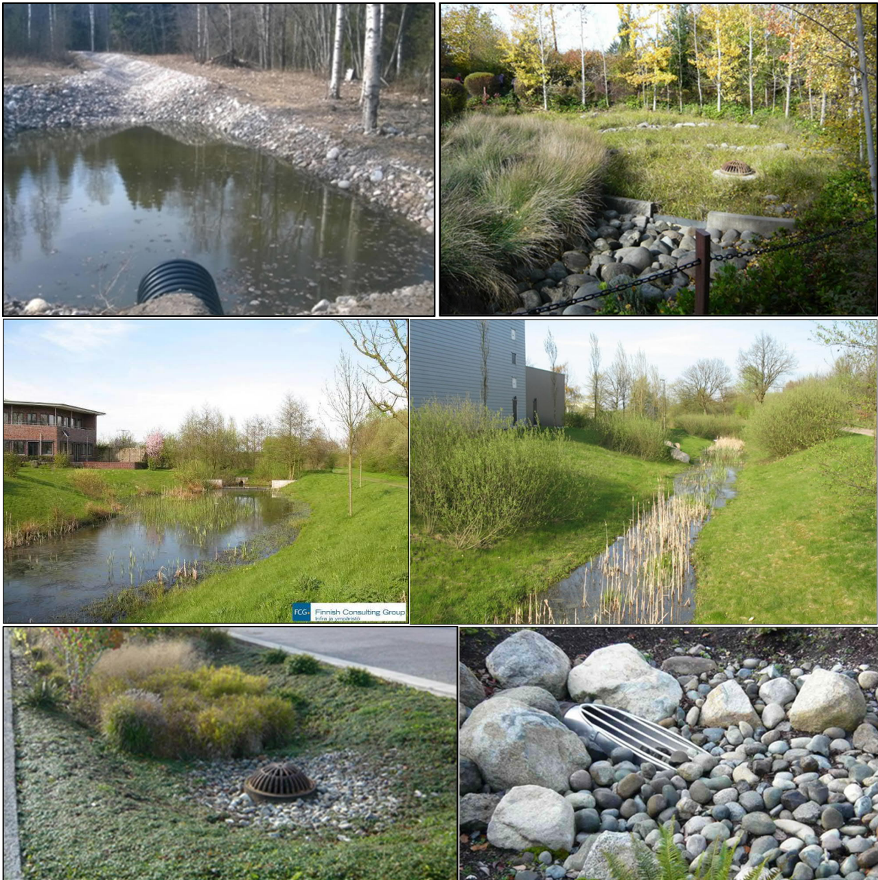
Kuva 5. Esimerkkejä viivytyksestä, eroosiosuojauksesta ja katualueen vesien johtamisesta. Neljä ylintä kuvaa: alueellinen viivytyks. 5 Vasen alakuva: Esimerkki katualueen viherpainanteesta, jossa on ylivuotojärjestelmä hulevesiviemäriverkkoon (Seattle, USA). 5 Oikea alin kuva: hulevesiviemäriin purkupanen yhteyteen rakennettu eroosiosuojaus. 5
