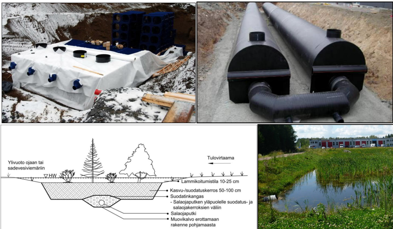
Kuva 6. Vasen yläkuva: Maanalaisen viivytystilavuudeltaan 300 m 3 kennoston rakentamista Tampereen Tykkitiekkadulla. Oikea yläkuva: esimerkki vedenpitävästä säiliöstä 6 . Vasen alakuva: Tyypin kuva biosuodatusrakenteesta 4 . Oikea alakuva: esimerkki hulevesien hallinnasta Tuusulassa. 5
